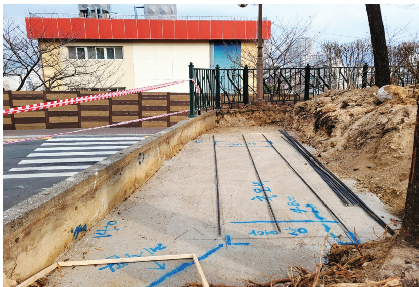
추모 동산 기초 공사.
